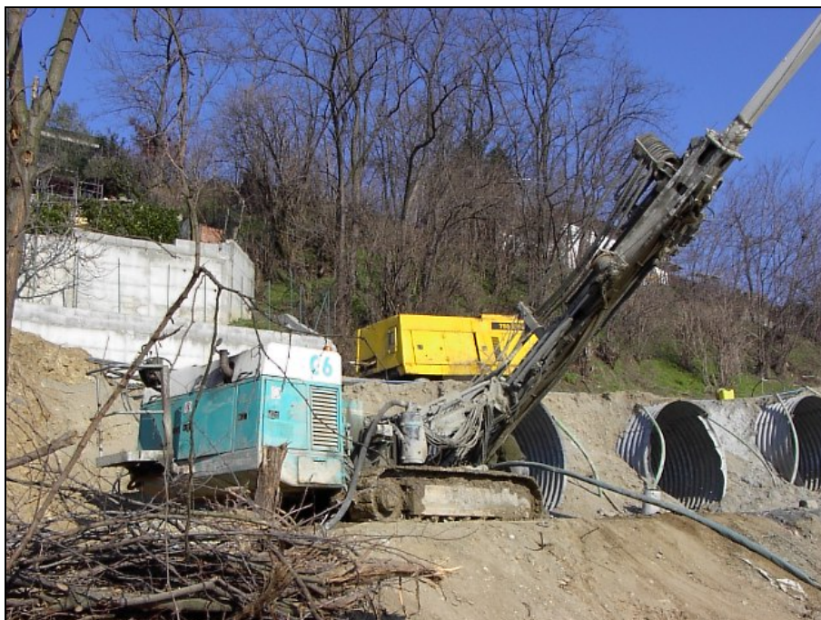
Intervento di risanamento versante in località Amistà / Rile Realizzazione di tiranti in trefoli d'acciaio
