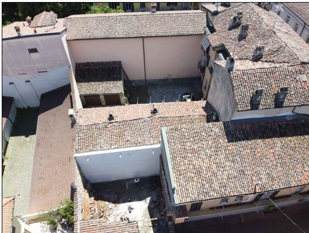
Foto 10: vista zenitale settore dell'area di intervento occupata dal rustico già demolito
