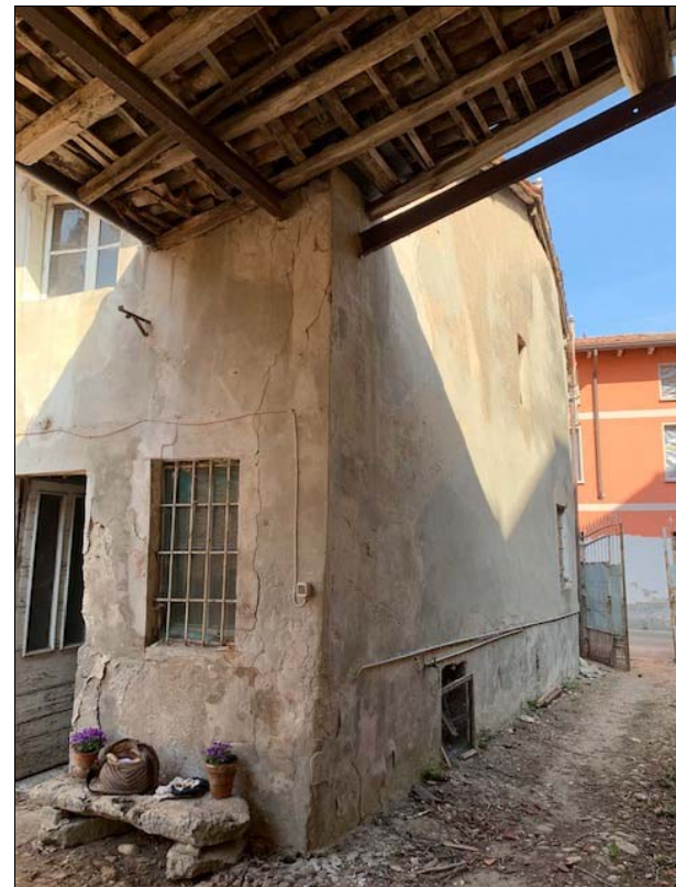
Fotografie 7-8: tettoia in aderenza al muro di confine est e particolare di collegamento col fabbricato ad uso residenziale
