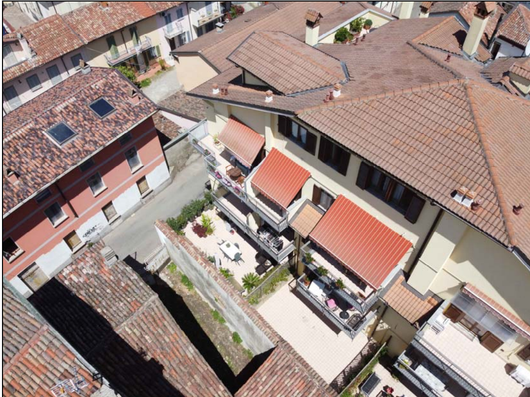
Foto 11: vista zenitale settore dell'area di interventi prospiciente via Bottini
