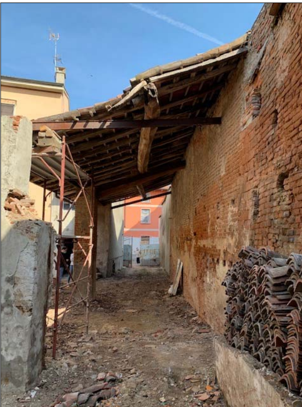
Fotografie 7-8: tettoia in aderenza al muro di confine est e particolare di collegamento col fabbricato ad uso residenziale
