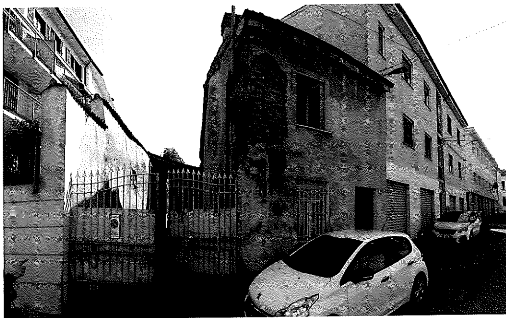
Figura 2: rilievi fotografici (vista fabbricato oggetto di intervento da via Bottini)
