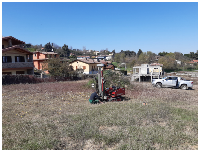
Prova penetrometrica statica CPT2
