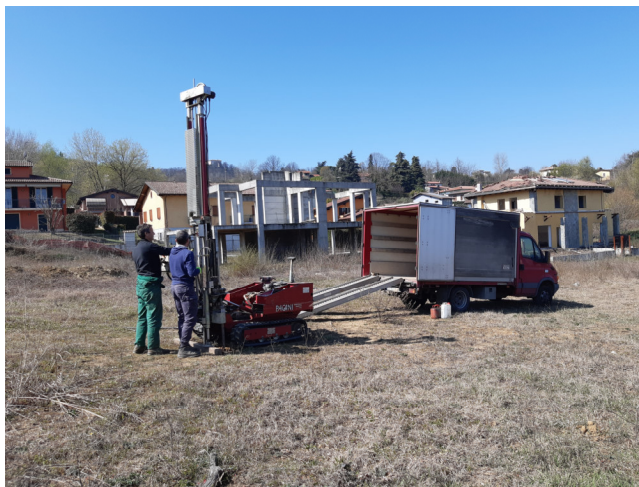
Prova penetrometrica statica CPT1
