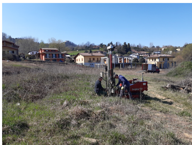
Prova penetrometrica statica CPT3
